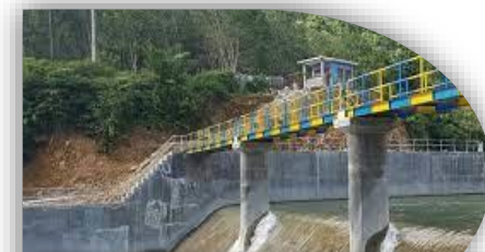
Pembangkit Listrik Tenaga Mikrohidro
